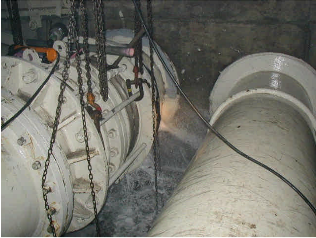
海水管漏えい部全景
