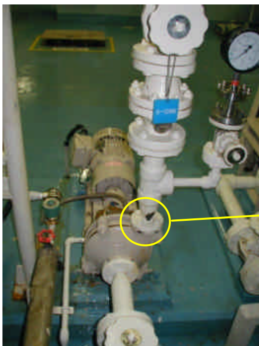
排泥ポンプ全景
