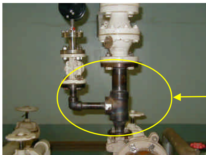
排泥ポンプ出口配管の取替え状況
