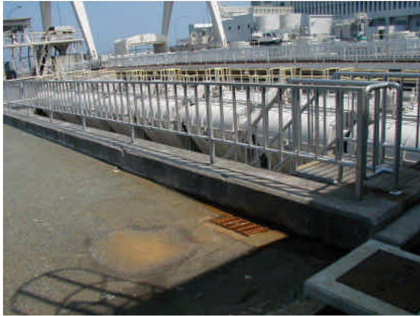
洗淨作業現場
