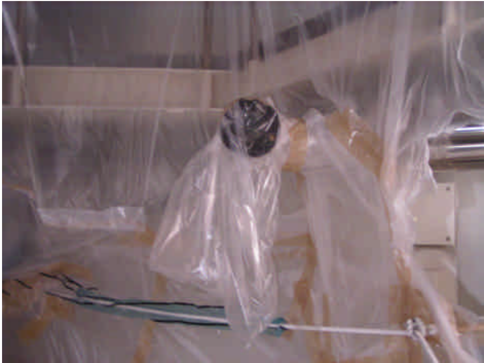
漏えいのあった配管フランジ部
