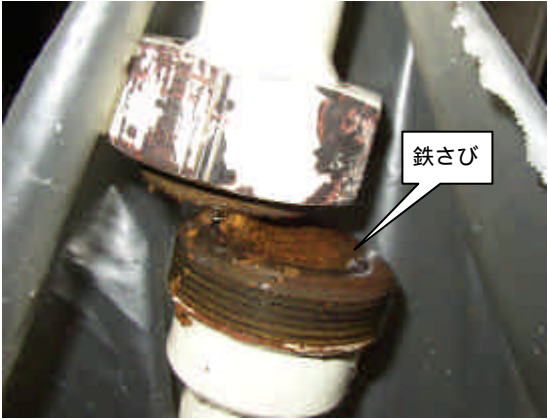
ドレン配管閉塞状況
