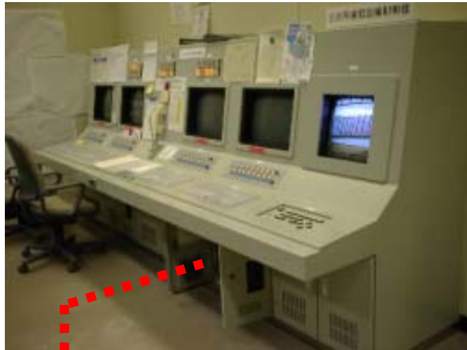
2次系補助設備制御盤
