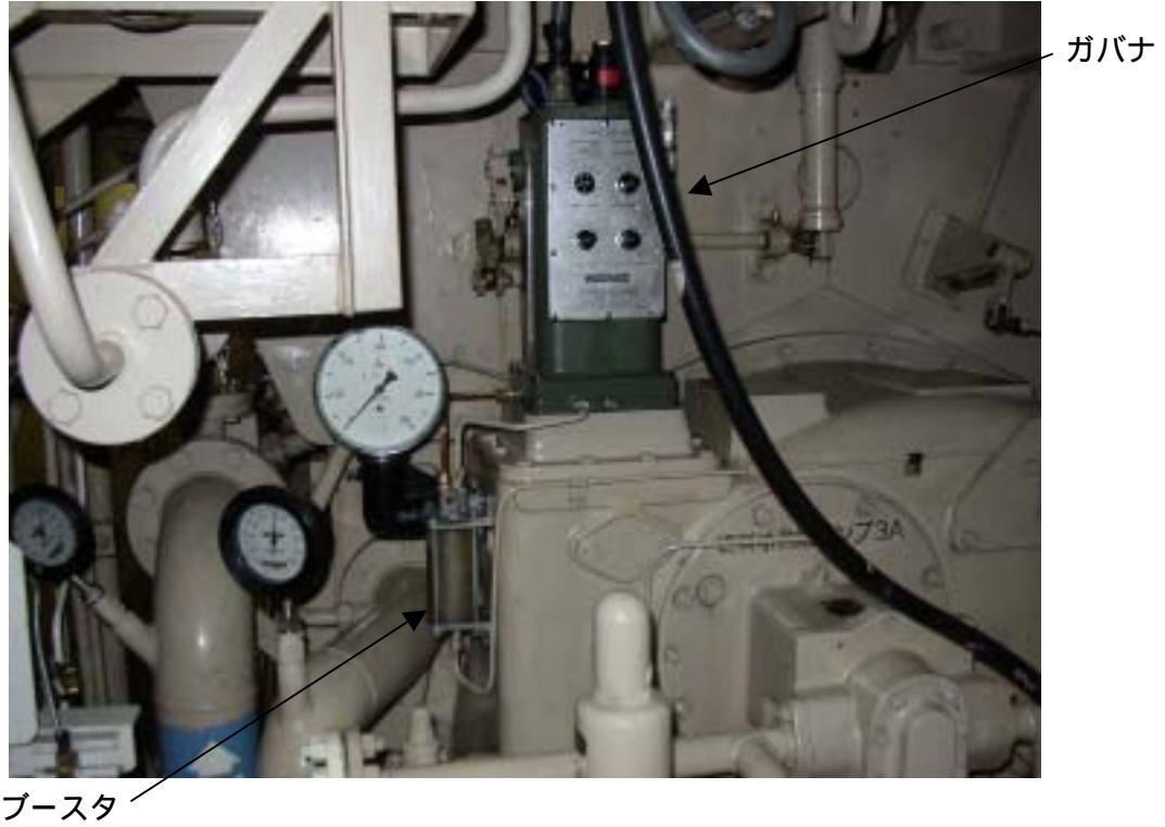
ガバナ・ブースタ取付状況
