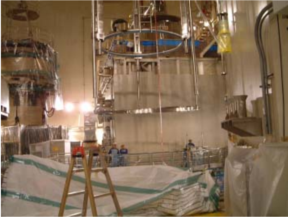
補助リング状況写真
