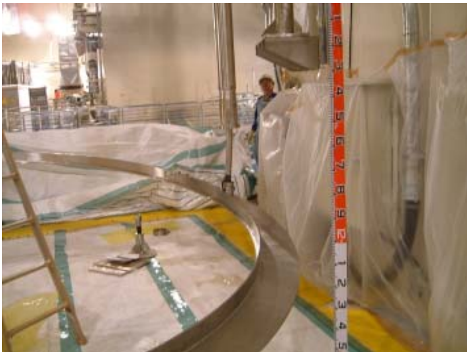
補助リング操作棒状況写真
