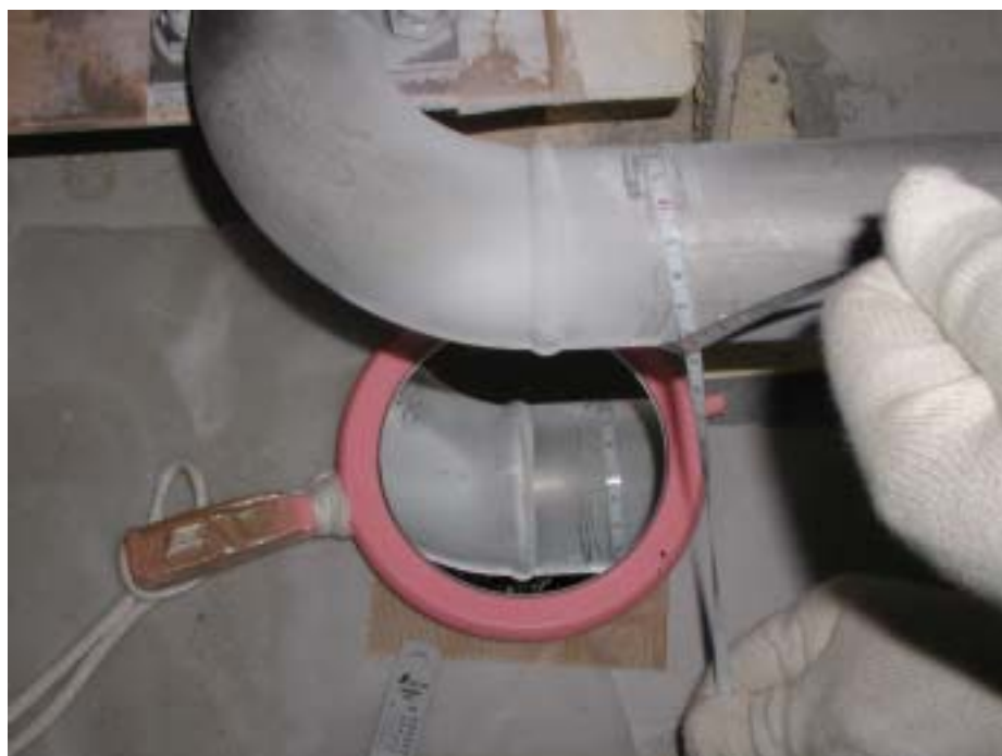
液体浸透探傷検査（補修後）
