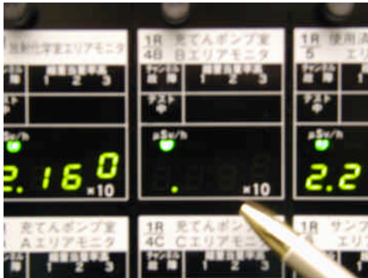
充てんポンプ室エリアモニタのデジタル表示部 (中央制御室)
