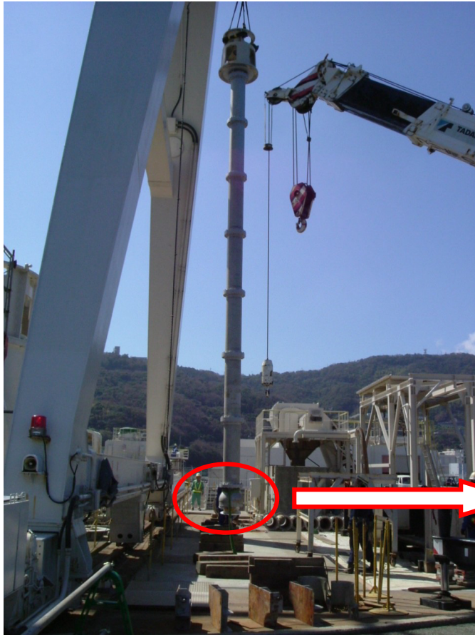
ポンプ本体の吊り上げ状態
