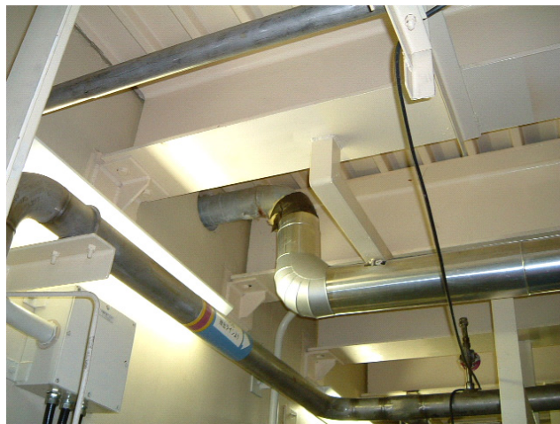
現在使用されていない所内用水配管と 冷却材貯蔵タンク戻り配管
