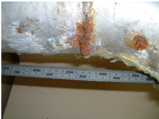
現在使用されていない所内用水配管
