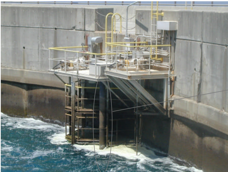
伊方1, 2号機放水口水モニタ設置状況
