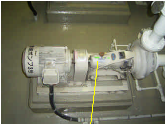
復水脱塩装置洗浄循環ポンプ全景
