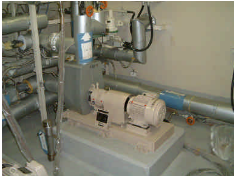
ほう酸濃縮液ポンプ 2 A 全景
