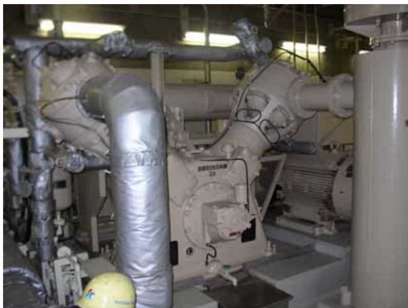
制御用空気圧縮機
