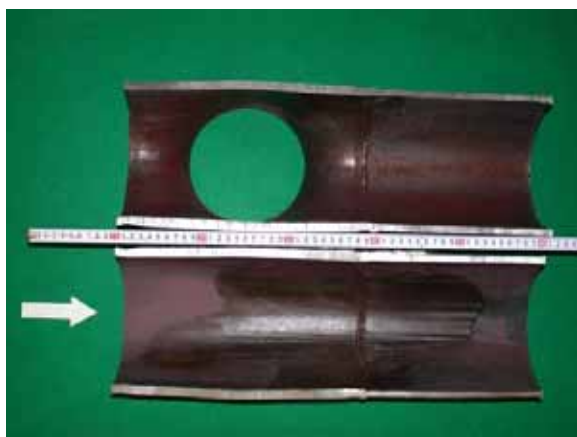
切り出し配管内面
