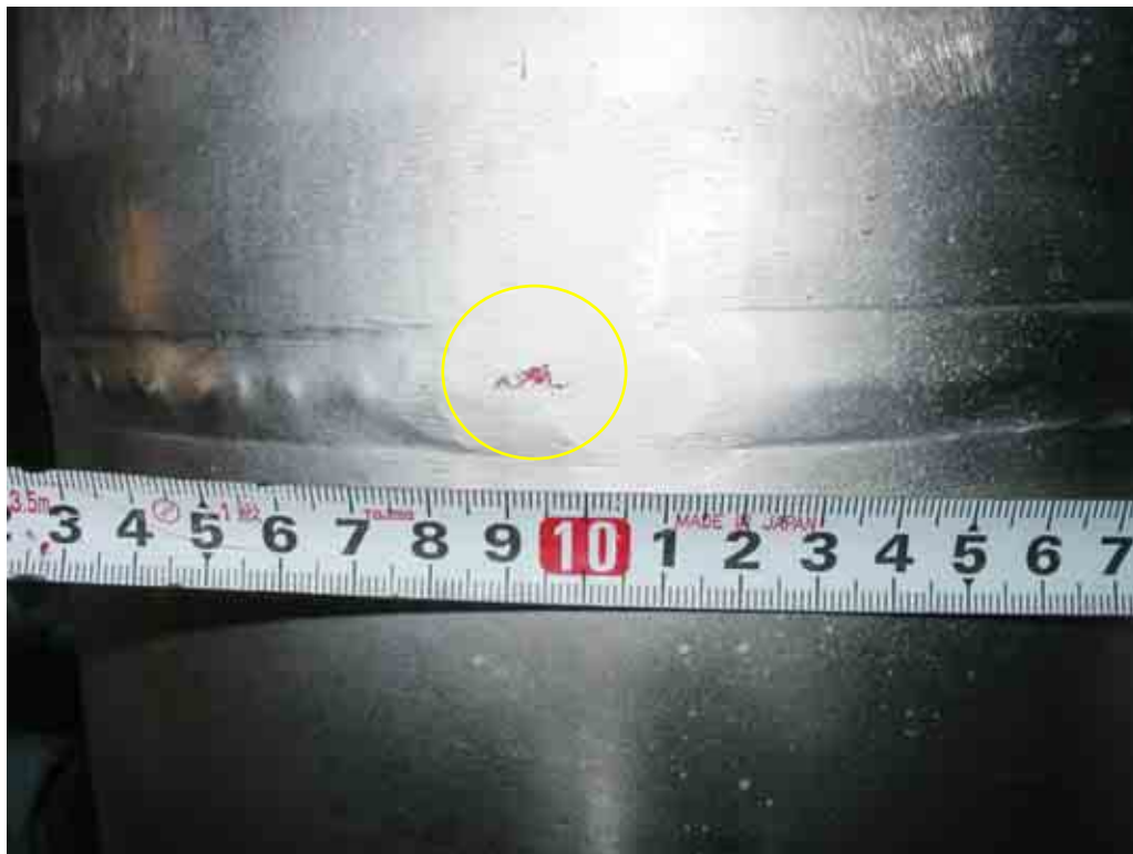
液体浸透探傷検査状況
