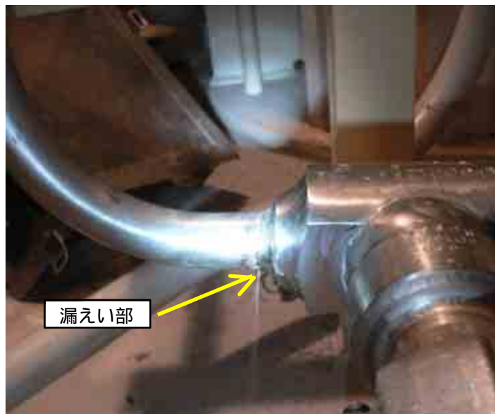
漏えい箇所（発生時）
