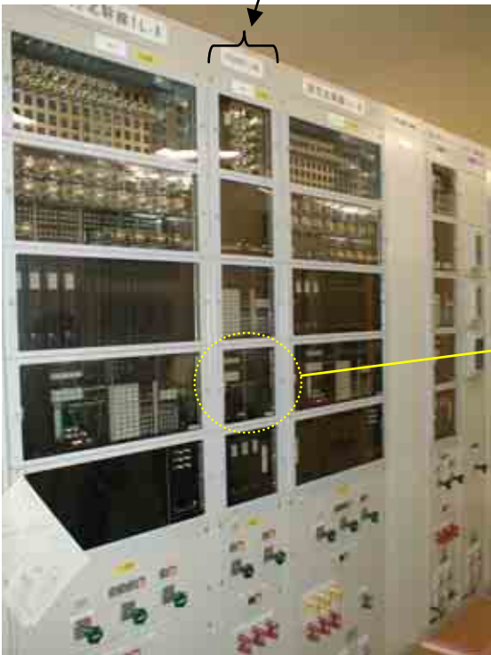
現地盤（伊方北幹線 1 L 後備保護リレー）
