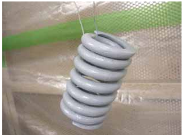
バネ部(防錆材塗布後)
