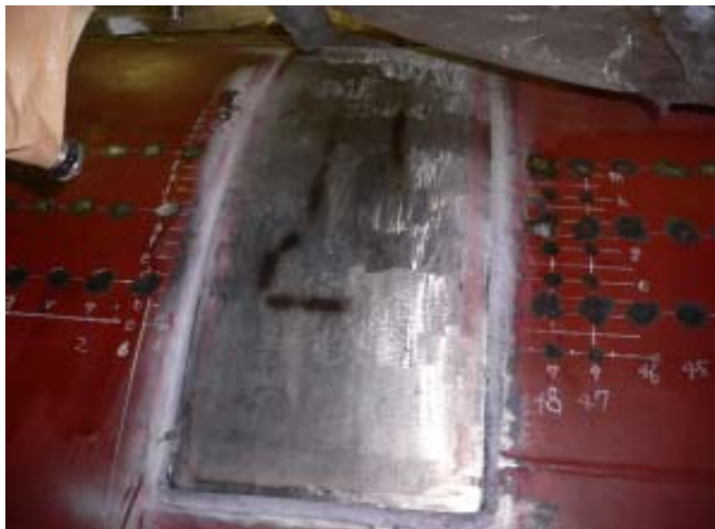
当て板溶接補修後の状況
