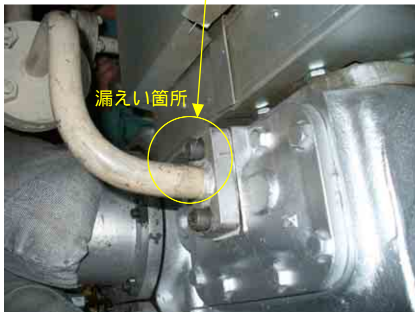
非常用ディーゼル発電機の冷却水配管からの漏えい箇所
