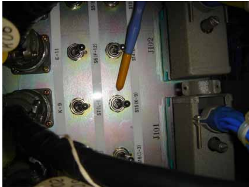
制御棒位置指示装置盤裏面のテストスイッチ
