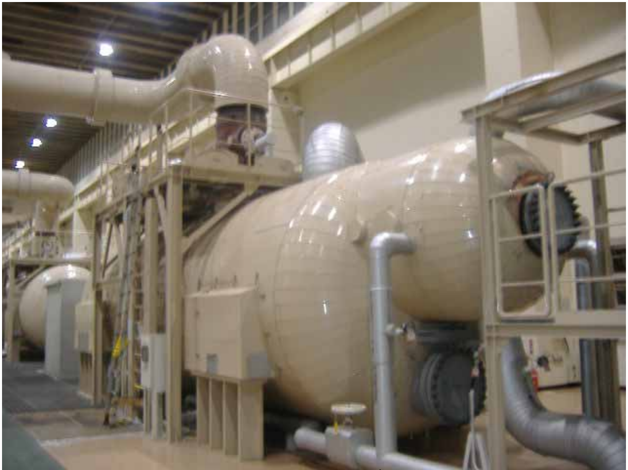
湿分離加熱器 1 A 全景(タービン建家 2 階)
