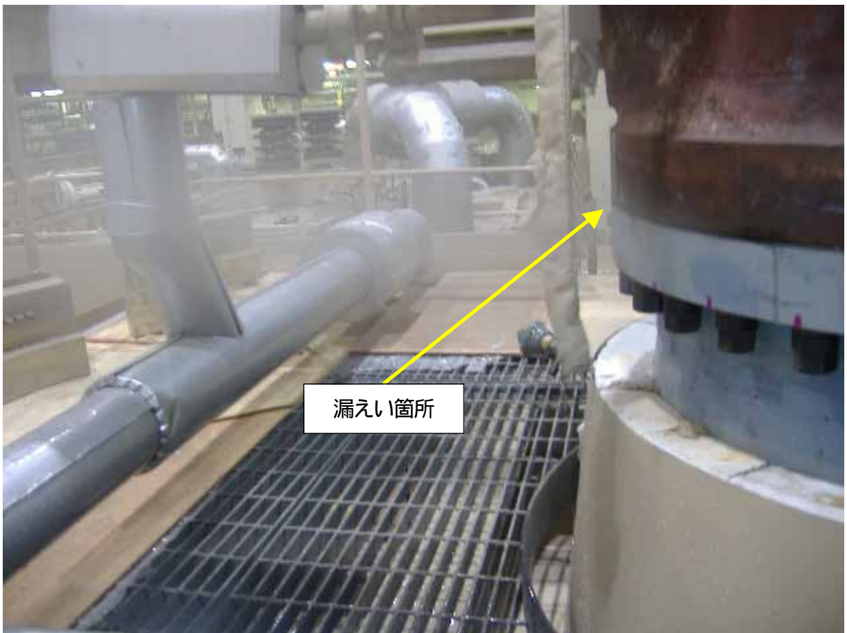
湿分離加熱器 1 A 出口フランジ部からの蒸気漏えい状況(タービン建家 2 階)
