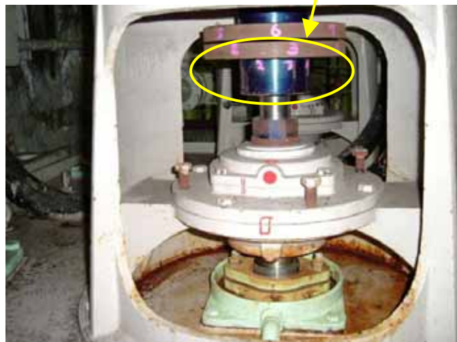
ポンプ軸写真
