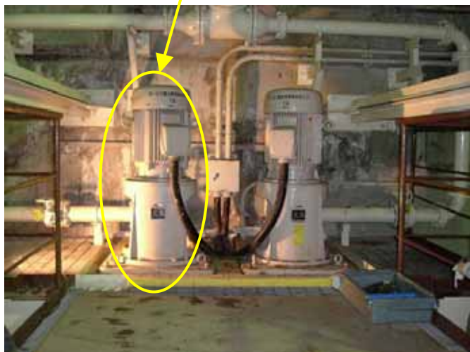
非常用排水ポンプモータ写真
