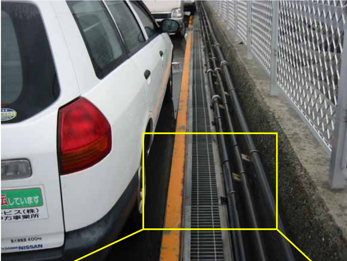
駐車状況写真
