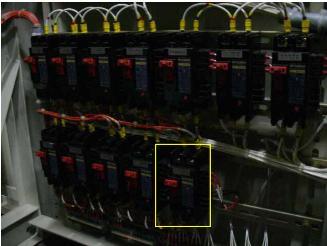
計装用電源(チャンネル )電源スイッチ
