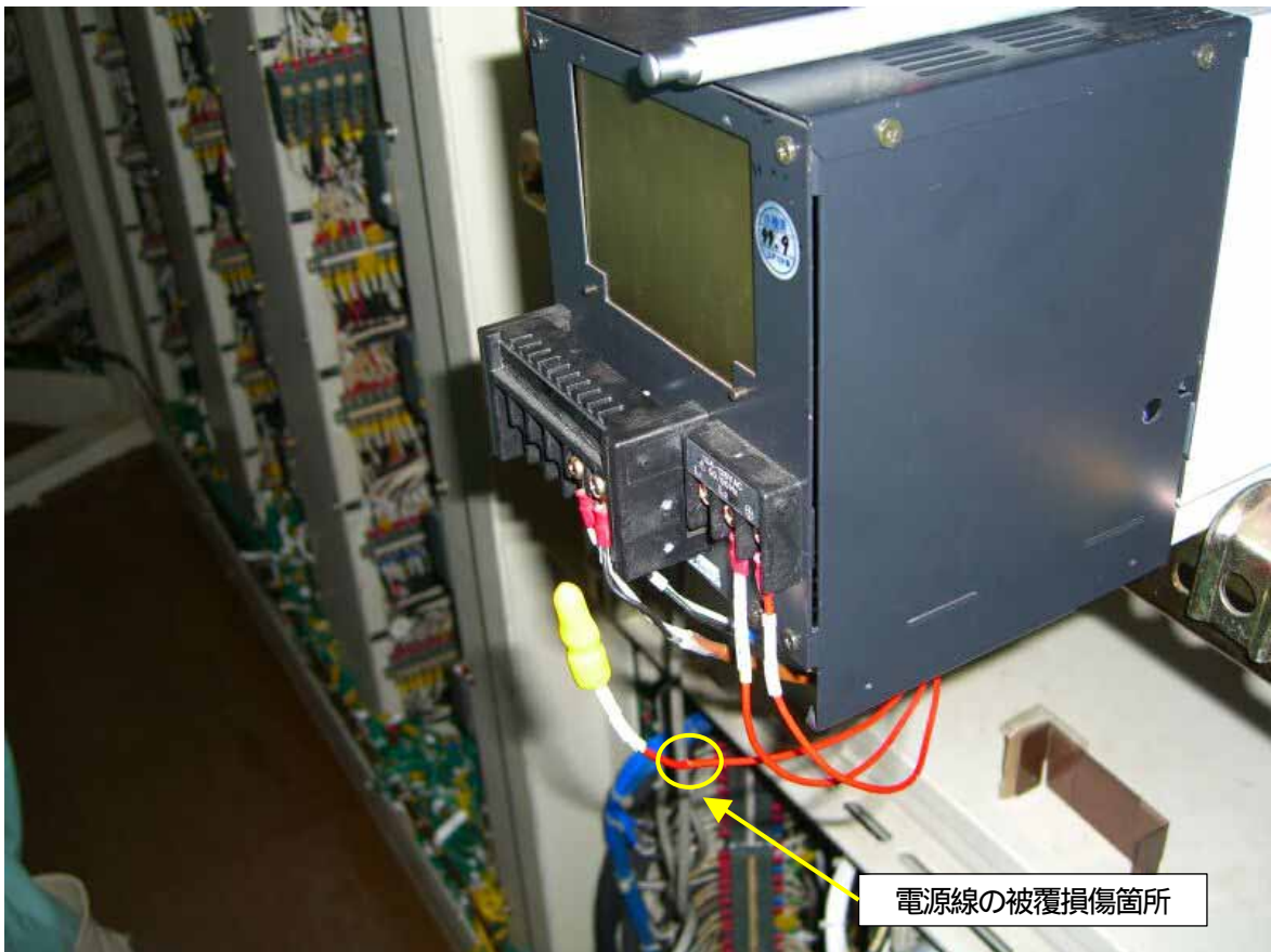
高圧注入ライン流量記録計(背面)
