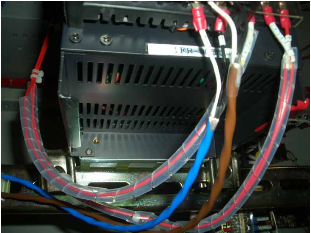
電源線復旧状況(拡大)
