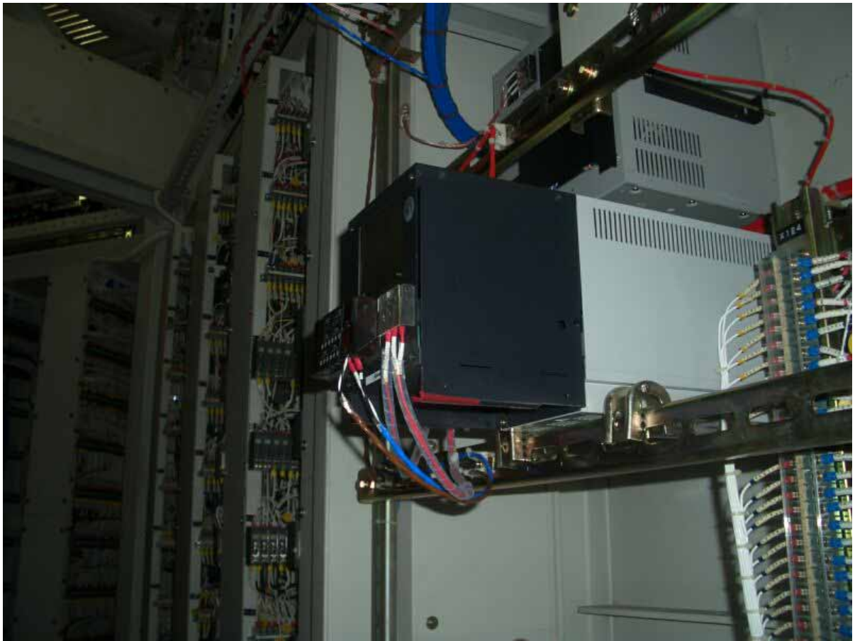
電源線復旧状況
