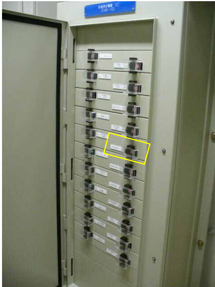
原子炉盤( )電源スイッチ
