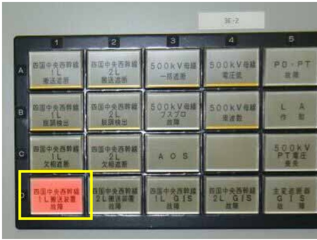
保護リレー異常警報表示
