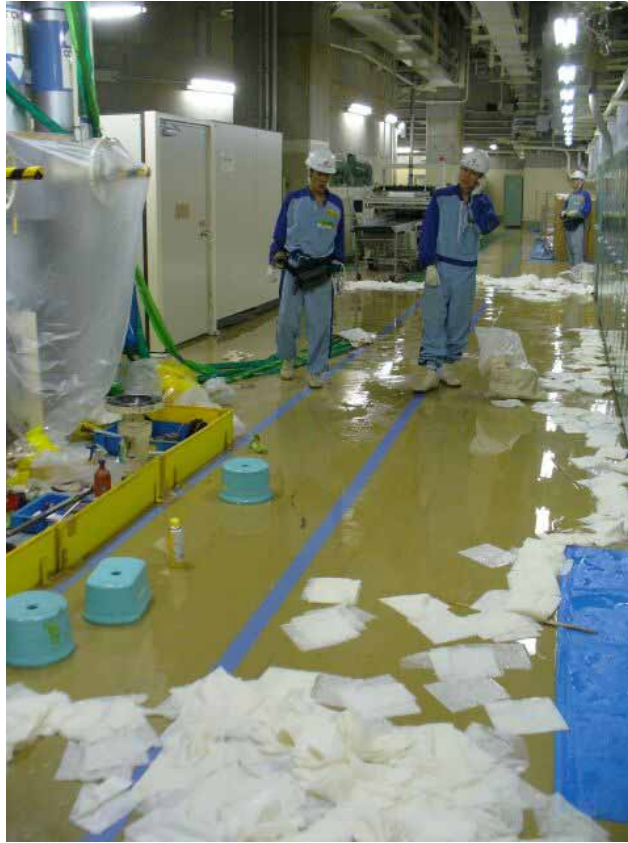
原子炉建屋 1階通路部漏えい状況(水たまり約 15m × 5m)
