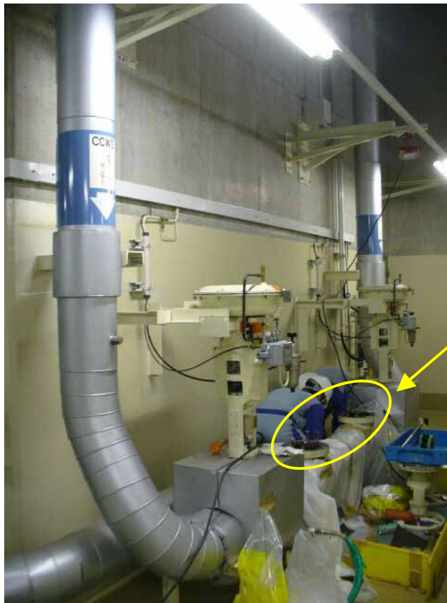
格納容器空調装置A、B 出口配管の弁
