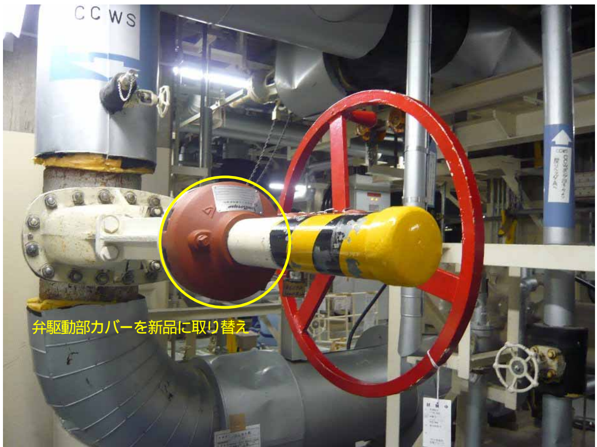
弁駆動部カバー復旧状況
