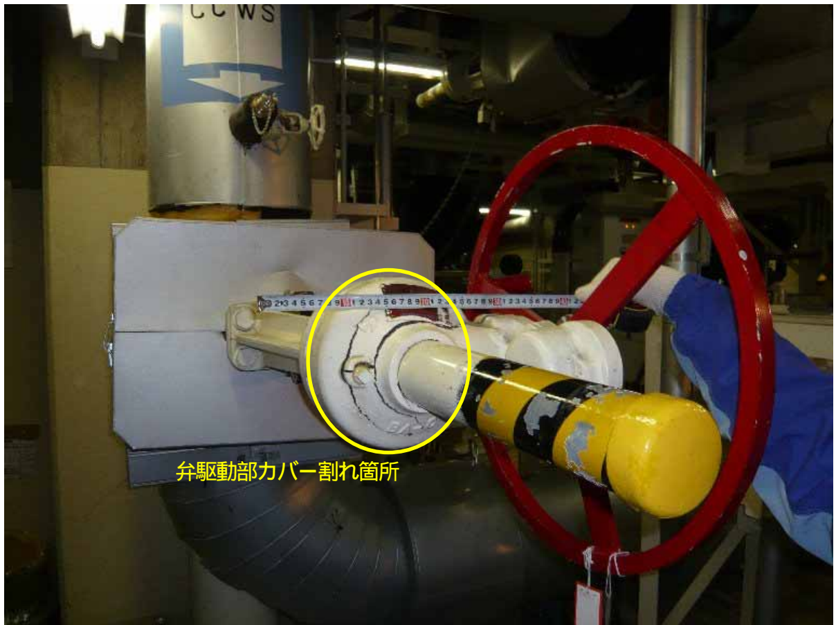
原子炉補機冷却水ポンプ 2 B 入口手動弁の弁駆動部カバー割れ状況
