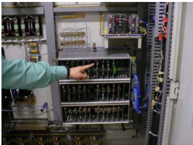
現場制御盤内故障表示ランプ点灯
