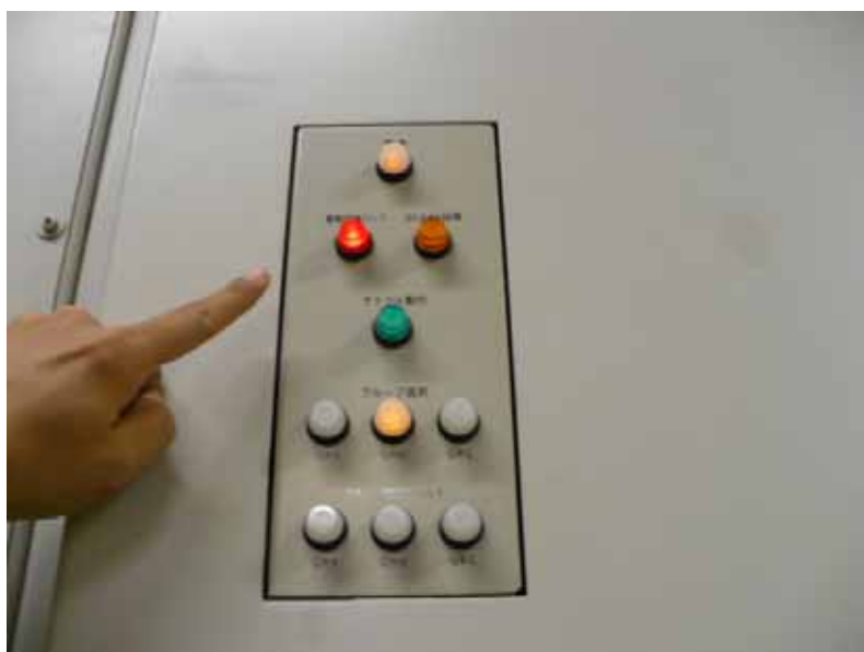
現場制御盤警報発信
