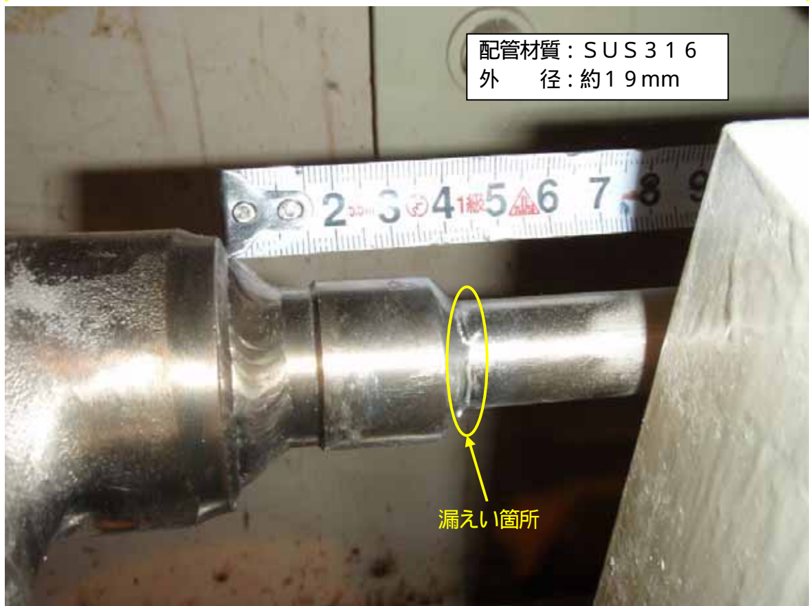
蒸気漏えい箇所
