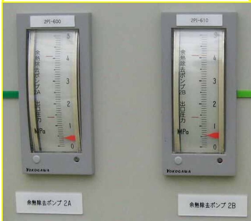
余熱除去ポンプ 2 B 圧力計(中央制御室)
