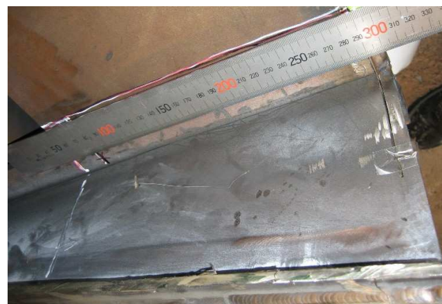
蒸気整流板内側
