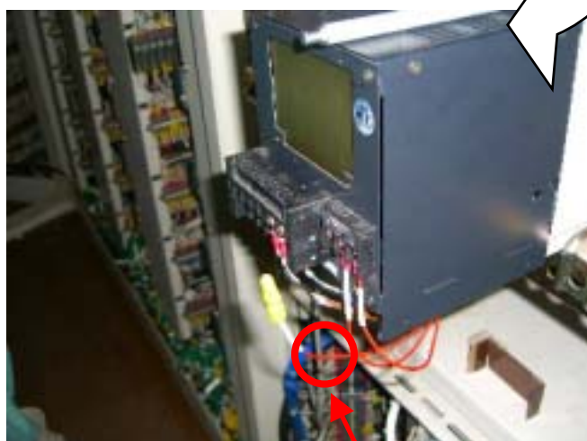
高圧注入ライン流量記録計（中央制御盤内）
