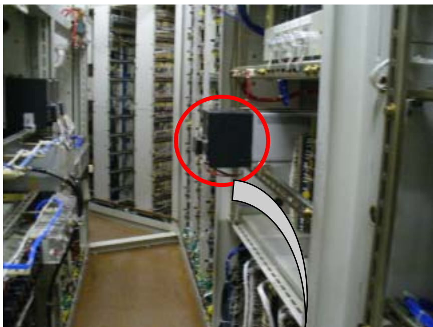
中央制御盤内
