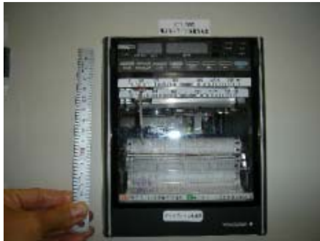
高圧注入ライン流量記録計
