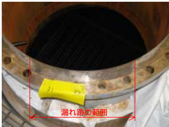
[漏えい部の湿分分離加熱器1A出口フランジ面]
