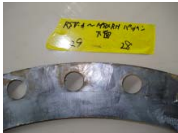
[漏えい部のガスケット面(湿分分離加熱器側)]
