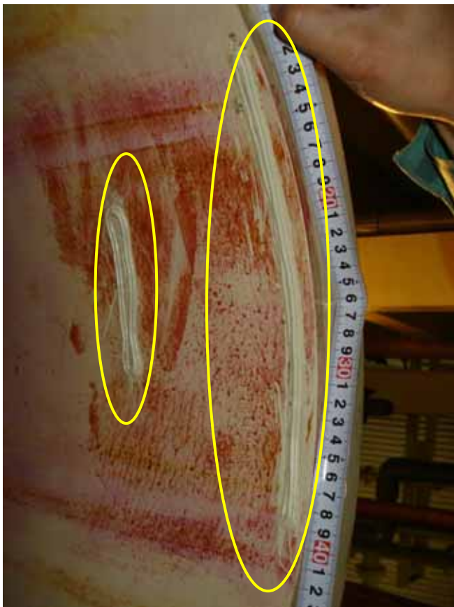
補修状況(配管内面)
