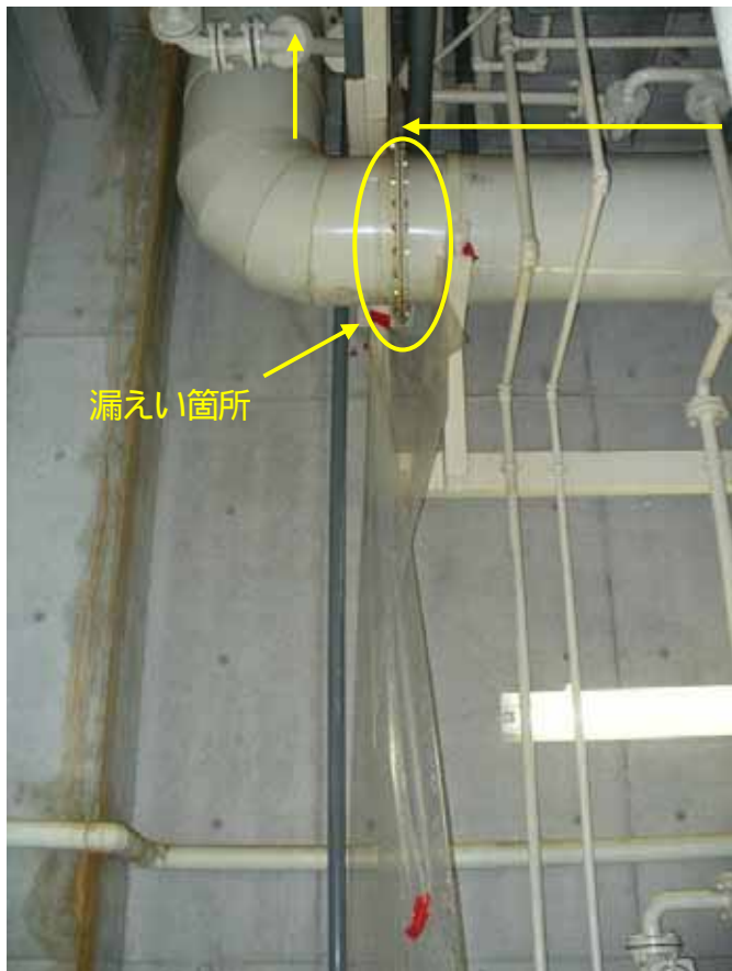
漏えい箇所(建屋内)
