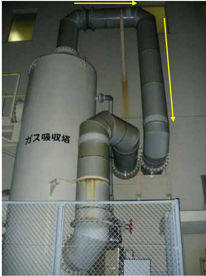
ガス吸収塔(建屋外)
