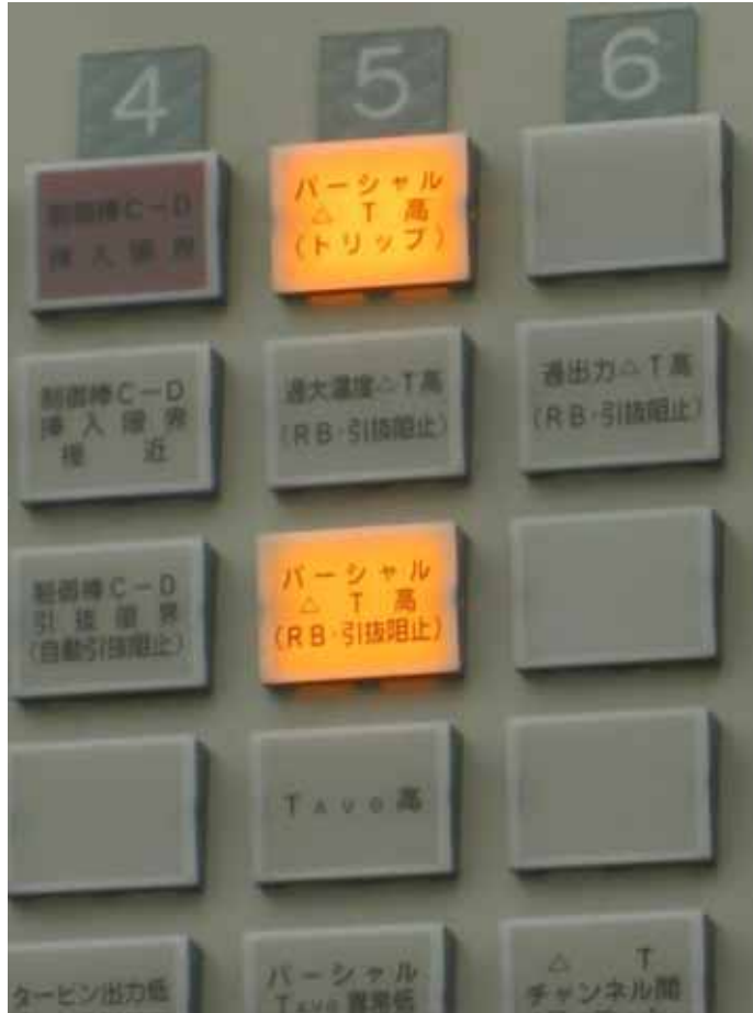
中央制御室制御盤 警報状況
