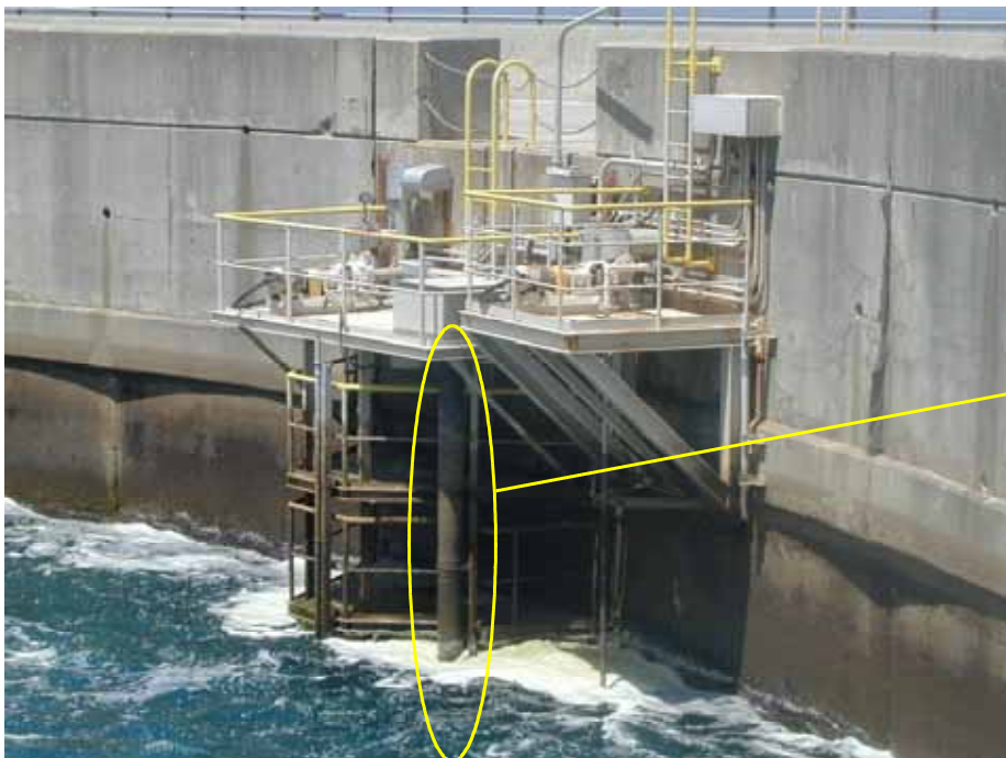
伊方1, 2号機放水口水モニタ設置状況
