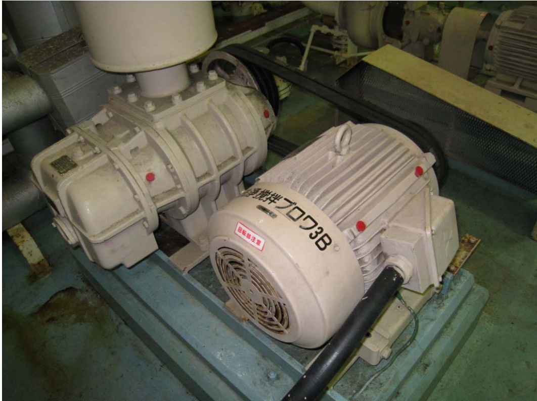
海水淡水化装置 洗浄攪拌ブロワとモータ
