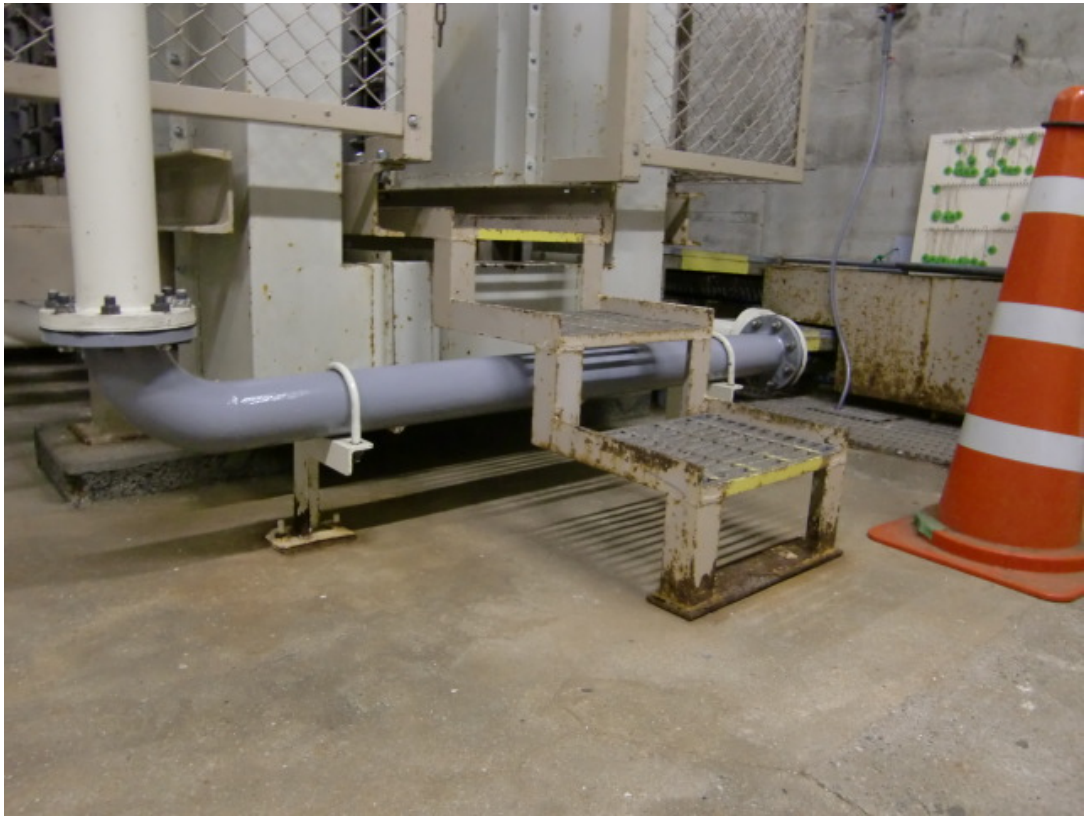
復旧状況（仮設配管に取替えている）
