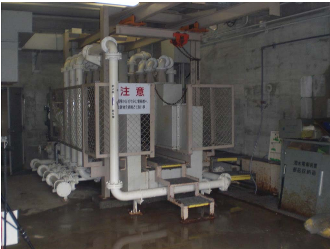
1、2号機海水電解装置
