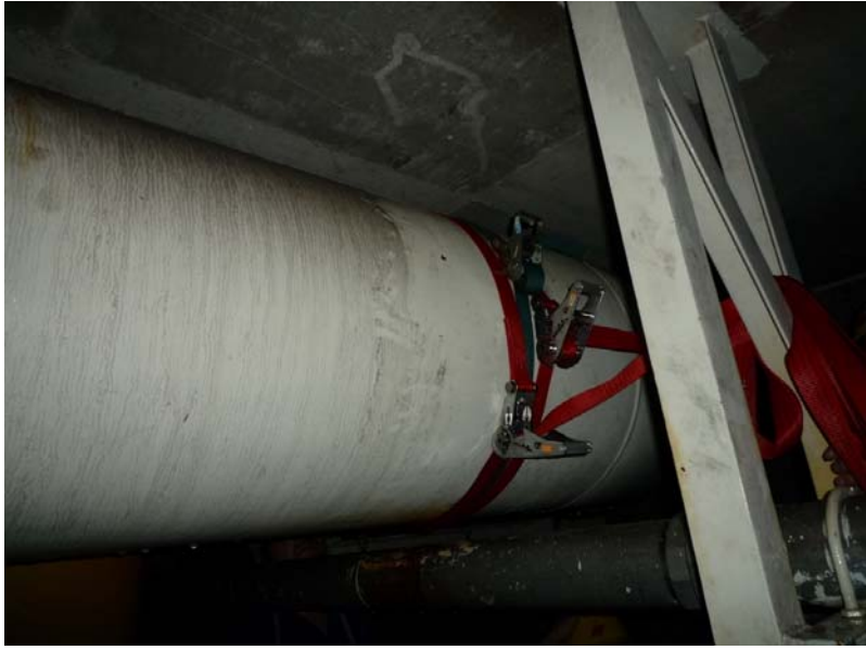
配管保修状況
