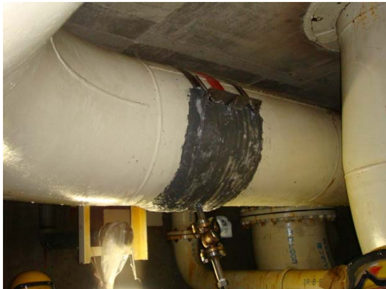
配管保修状況（接着剤塗布後）
