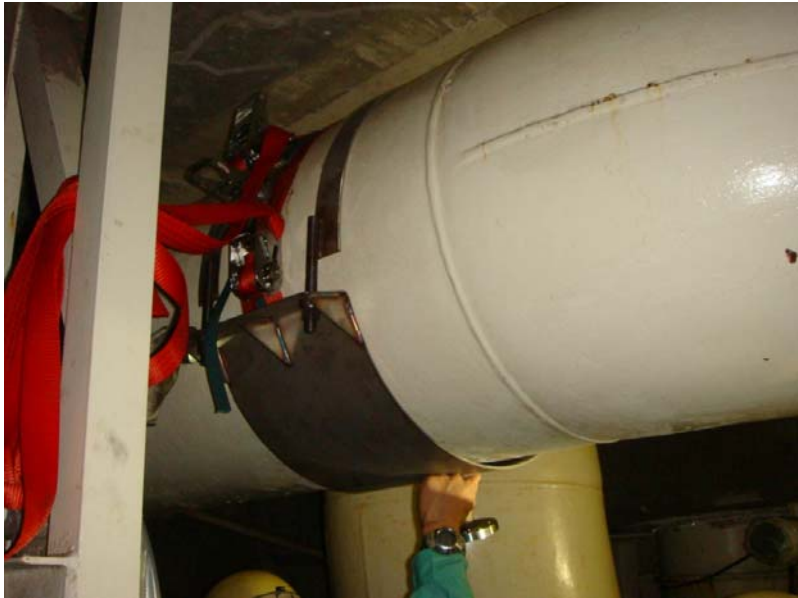
配管保修状況（接着剤塗布前）
