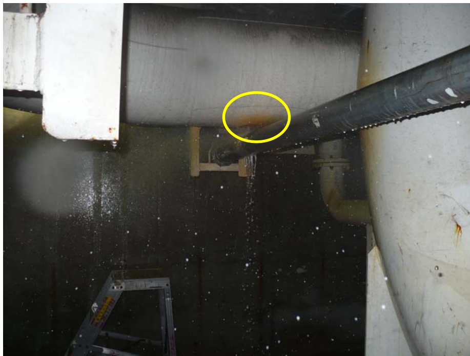
2次系補機冷却用海水配管からの漏えい
