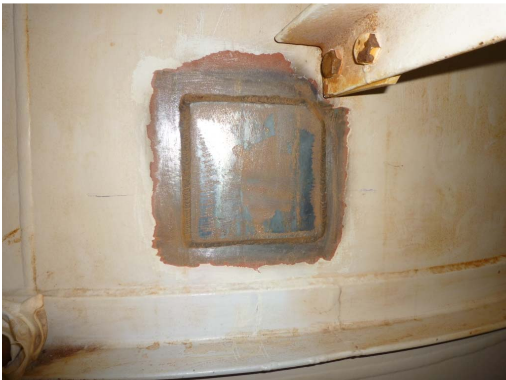
外面保修状況（胴板を溶接（約 120mm × 120mm）
