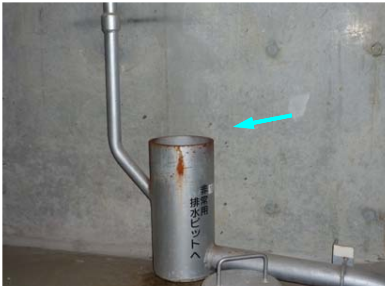
ドレン受けの蓋をはずした状態
