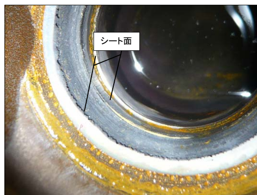
弁座 分解状態 (シート面にスケール付着)
