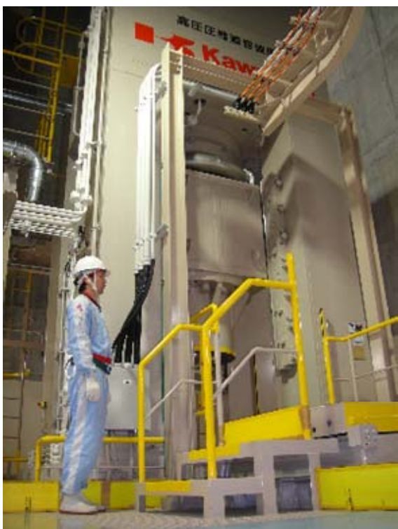
高圧圧縮減容装置
