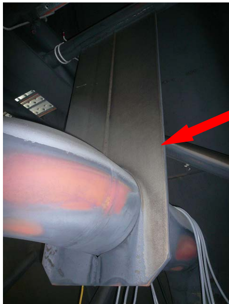
第2低圧給水加熱器ドレン管およびサポート(山側より見る)
