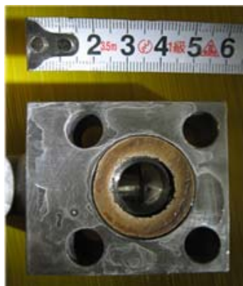
フランジ分解状況 (配管側)
