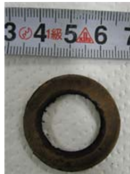
取出したガスケット
