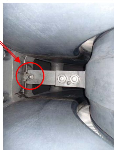
蒸気転向装置ボルト固定状況
